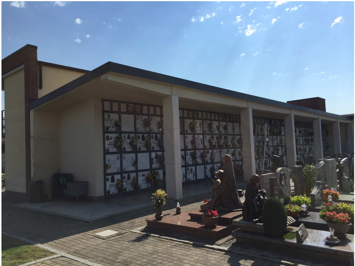
VISTA LOCULI E OSSARI EDIFICIO NORD DELLA PARTE PIU' ANTICA DEL CIMITERO COMUNALE
