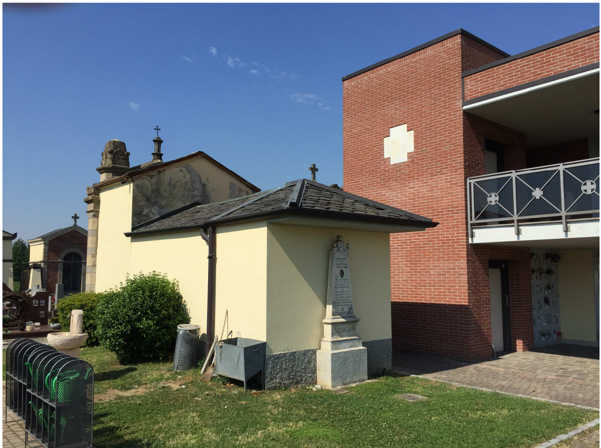
VISTA EDIFICIO SERVIZI IGIENICI E LOCALE TECNICO ASCENSORE
