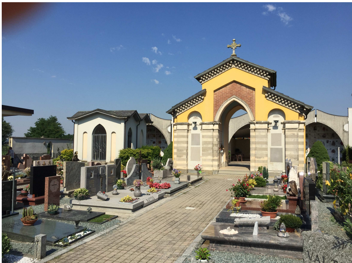
VISTA CAPPELLA SEPOLTURE SACERDOTI E DEPOSITO MORTUARIO/SALA AUTOPTICA
