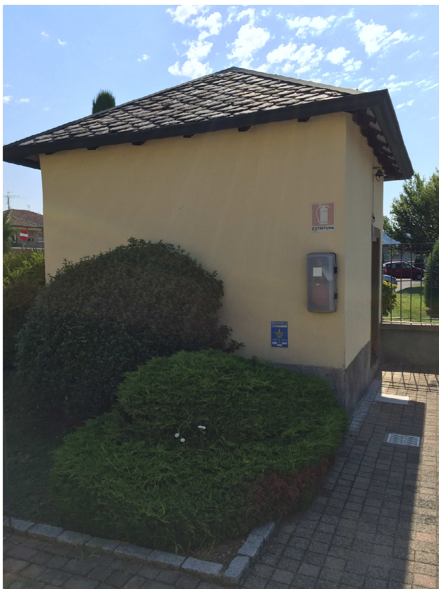
VISTA EDIFICIO AD UFFICIO E SPOGLIATOIO ADDETTI AL SERVIZIO
